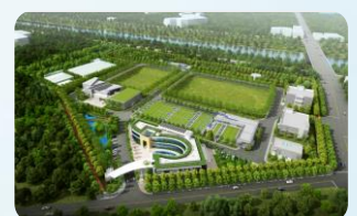
臺南永康水資中心 (及再生水廠)
