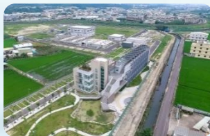
臺中市豐原水資中心
